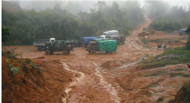
ເງື່ອນໄຂຂອງສະໜາມ ບ້ານ ຫວຍຊາຍ ການຝຶກອົບຮົມໃນສະໜາມ
